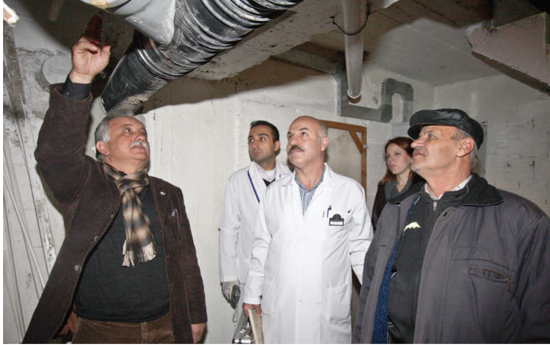
İzmirdeki binalar belediyeler tarafından denetleniyor. (Fotoğraf: Bayraklı Belediyesi)
